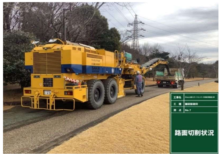
施工状況 (路面切削)
